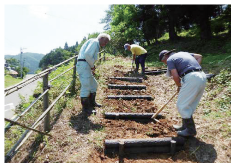
ハッピー山の遊歩道整備の様子
