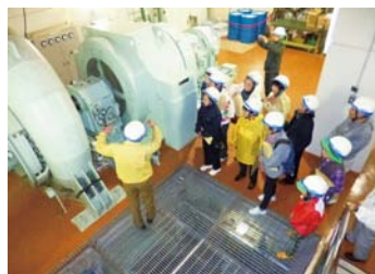
山口発電所(水力発電)の説明
