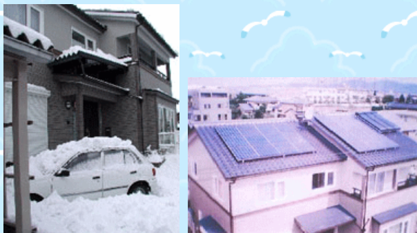
写真は、Y氏宅の太陽光発電と自動車の上 に落ちる雪のため追加した玄関上の小屋根
