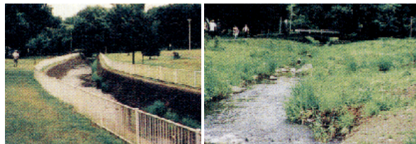
豊かな自然を保全し、創出することをめざした川づくり
