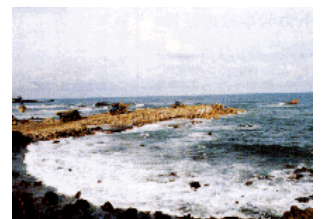
船首重油抜き取りのため仮説道路工事 (1月31日・三国町安島)
