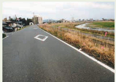
清掃後の板垣橋周辺
